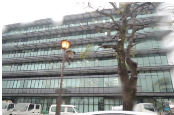
外装には被害は見受けられない
