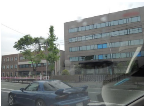
隣の3階建の建物のガラスには 被害は見受けられない
