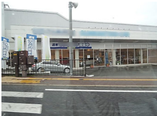
小寸法のガラス開口部には破損は見られない
