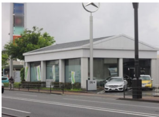
同じ敷地内の別棟のガラスには、ガラスの破損は見られない
