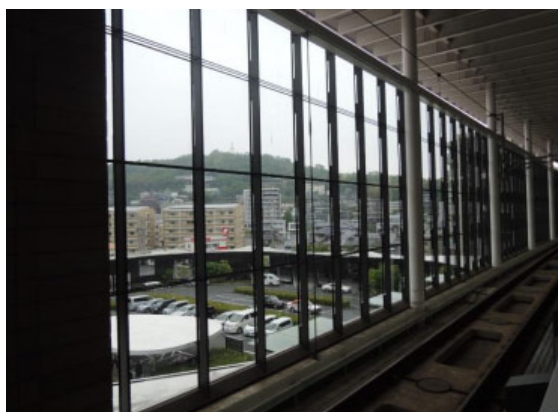
縦辺基調のカーテンウォール
