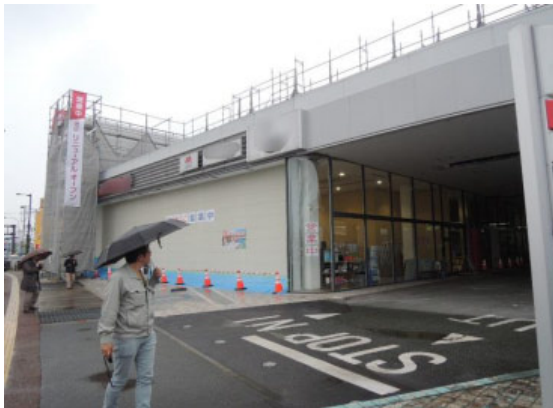
ガラスが破損したショールーム
