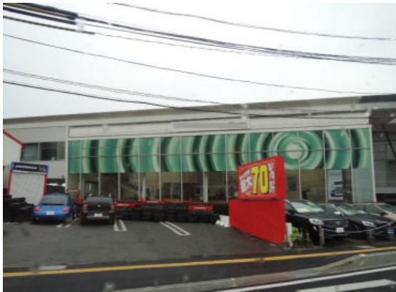
サッシ納まりによるガラス開口部 ガラスの破損は見受けられない
