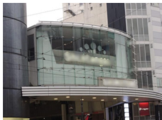
アーケード入口上部のガラススクリーン ガラスリブ+部分支持構法、破損無し
