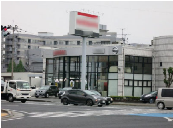
割り付け寸法の比較的小さなアルミCW ガラスの破損は見られない
