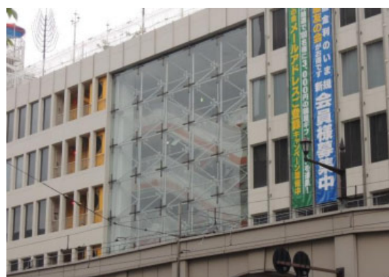
部分支持構法によるガラススクリーン かなり古い施工だが破損無し
