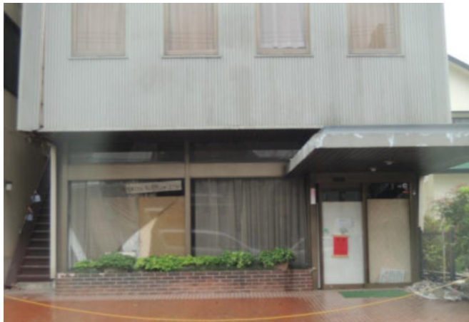
左側のガラスが破損している
