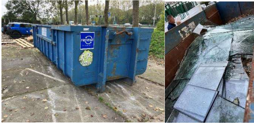
(写真) 改修工事現場用 およそ 1.5m × 6 m 廃複層ガラスを回収
