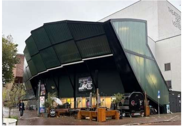
Delft U形のガラス（ Profilit ）の Facade
