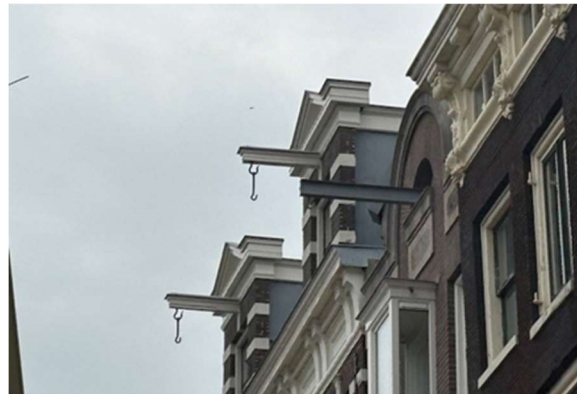
運河沿いの建築物の屋上吊り具
