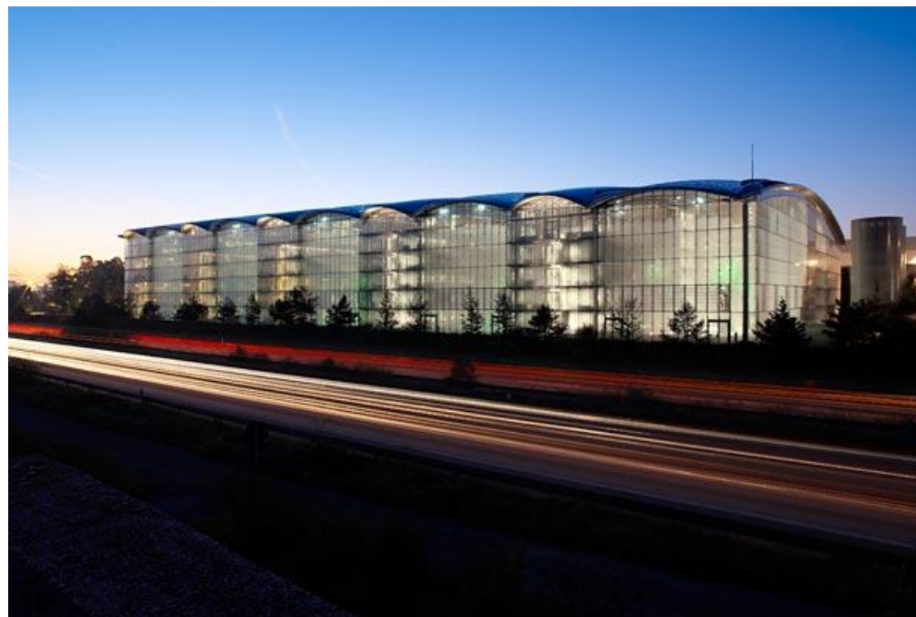
ルフトハンザ本社, 2006 Ingenhoven Architekten Frankfurt
